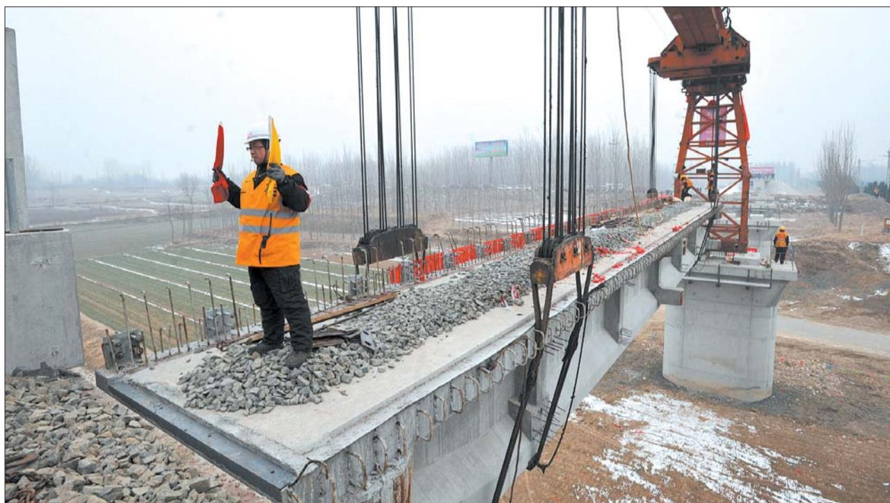
▲20日上午,在德州德大铁路漳卫新河大桥铺架现场,随着24米T形桥梁平稳准确落下,标志着德大铁路全线正式开始铺轨。
