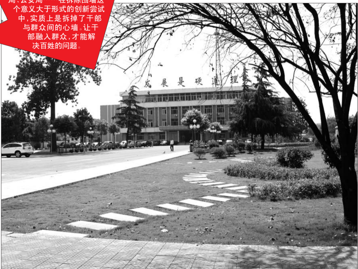
拆除围墙和大门后,微山县县委大院与奎文苑广场连成一体。
