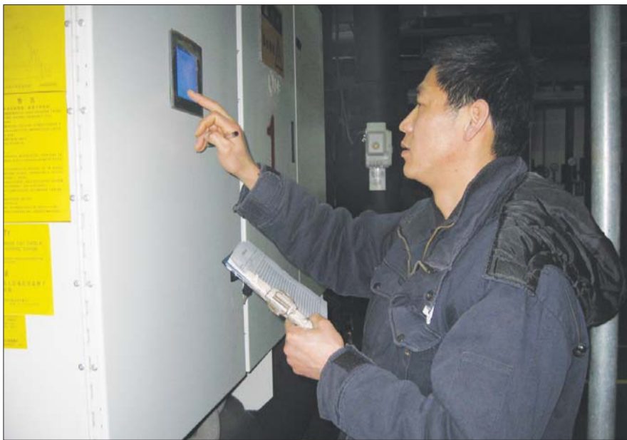
工作人员正在检查海水热泵机房的运行情况。
