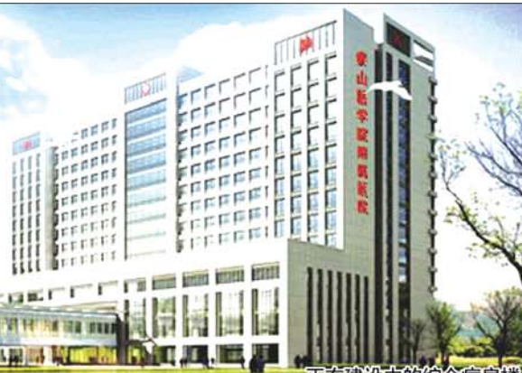
正在建设中的综合病房楼
