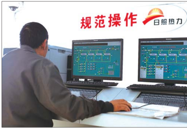
对市区供热管网的运行情况，工作人员实行24小时监控。
