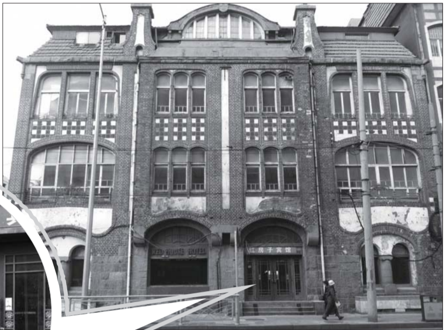
▲位于广西路33号的德占医药商店旧址全貌。本报记者 邱晓宇 摄 ◀广西路33号红房子近期将被修缮。本报记者 邱晓宇 摄
