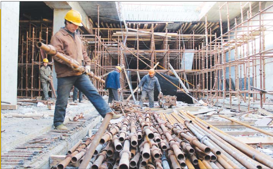
施工人员正在拆卸钢铁支架。
