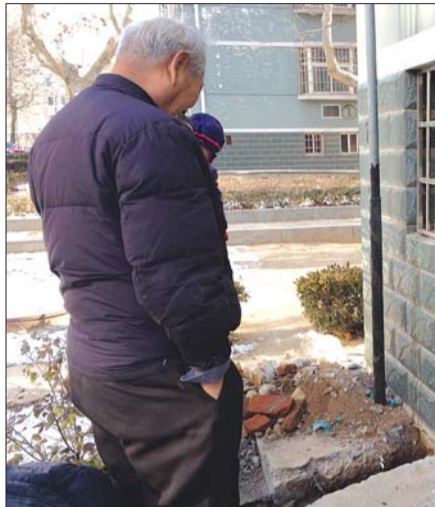
维修人员挖开地面,更换管道。图为居民过来查看。 本报见习记者 邹文鹏 摄
