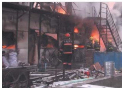
消防官兵正在灭火。消防供图
