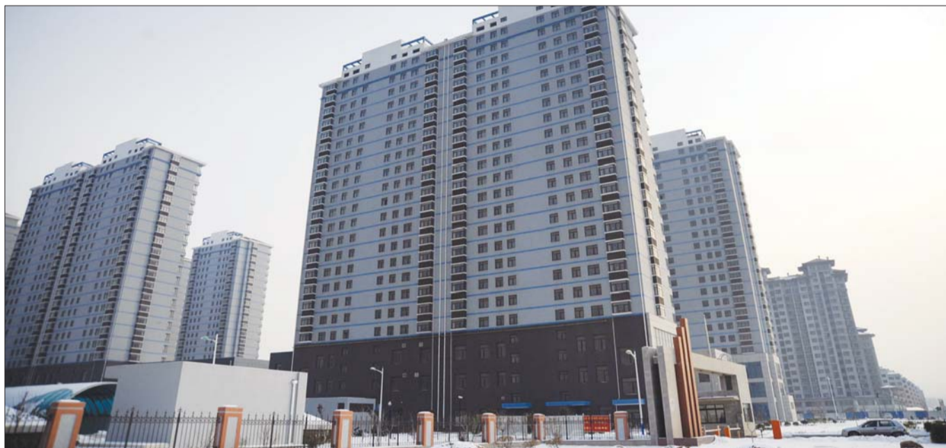
幸福西片区居民即将搬入的龙海家园。 记者 李泊静 摄
