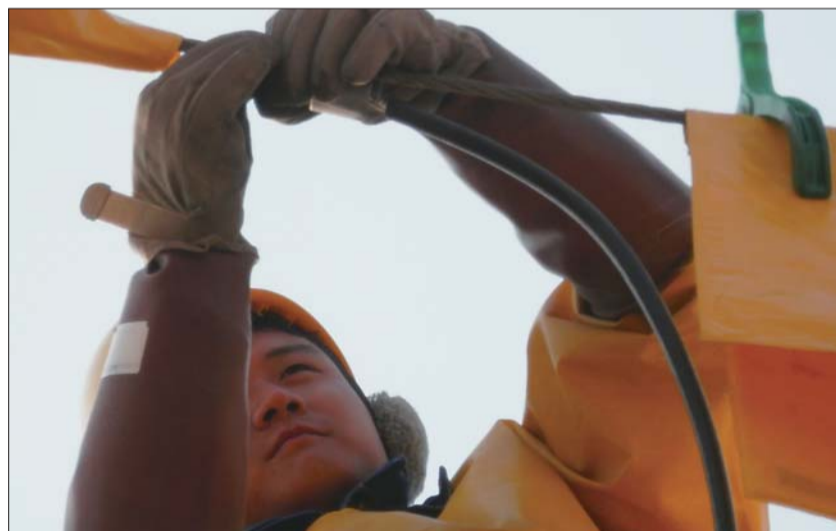
12月12日，张伟熟练进行绝缘手套法为某公司进行带电接火工作。（日照供电公司供图）
