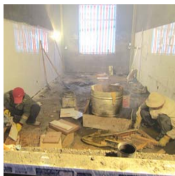
王庄小学两名工人正在施工。
