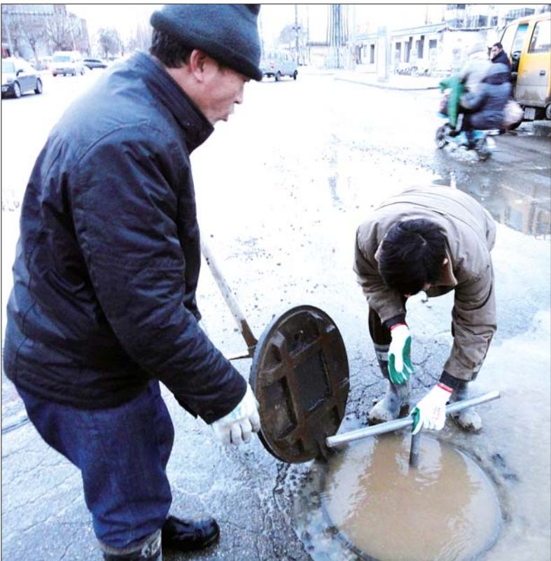
维修工人正在关闭阀门。本报见习记者 张林 摄
