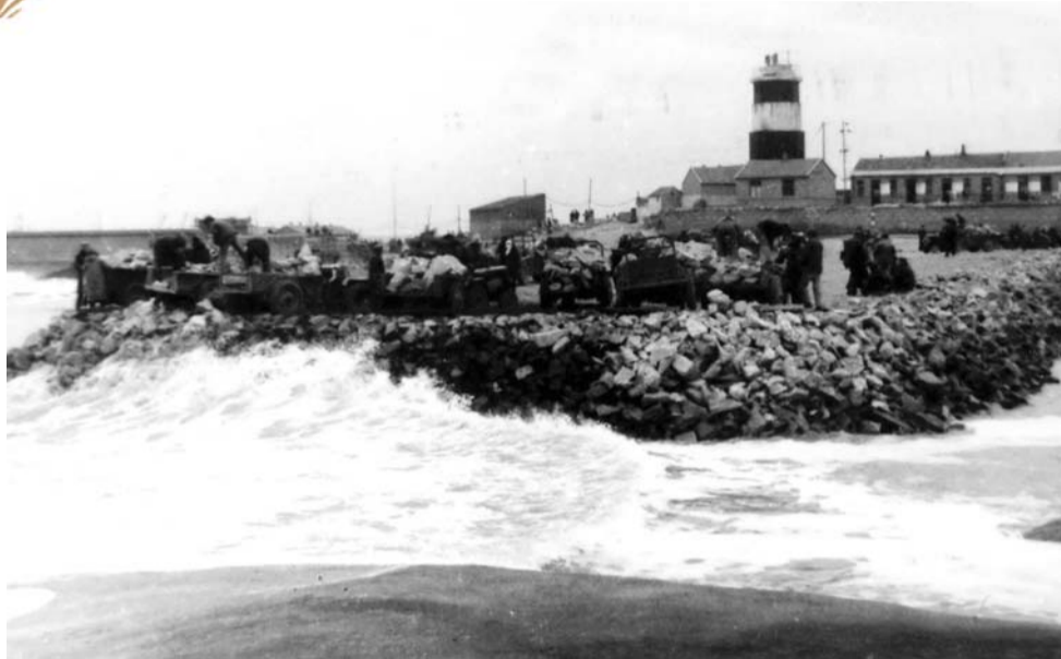
1982年2月17日,石臼港破土动工。图为煤码头建设初期填海现场(日照港提供)。
