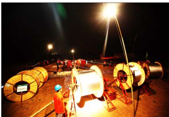
夜跨高铁施工保安全
