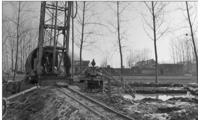
饮用水施工现场。
