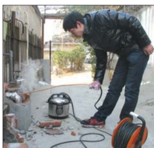
自来水公司工作人员用高压锅蒸汽给水管解冻。 本报记者 王世腾 摄
