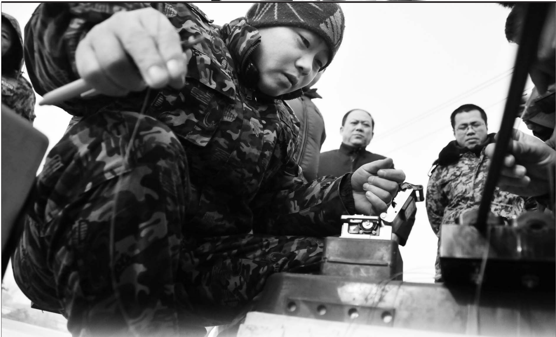
抢修队工人于东东正在熔接光缆线。
