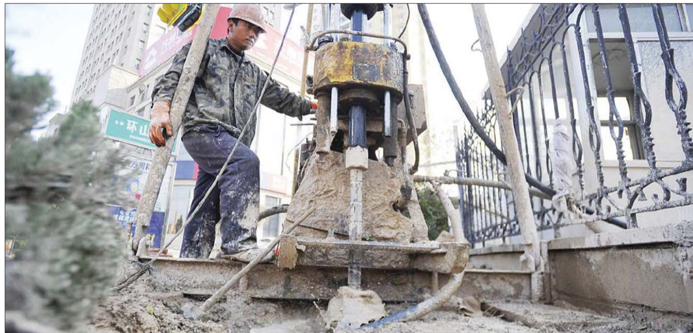
2012年12月6日,施工人员在省城经十路沿线进行地质初勘。
