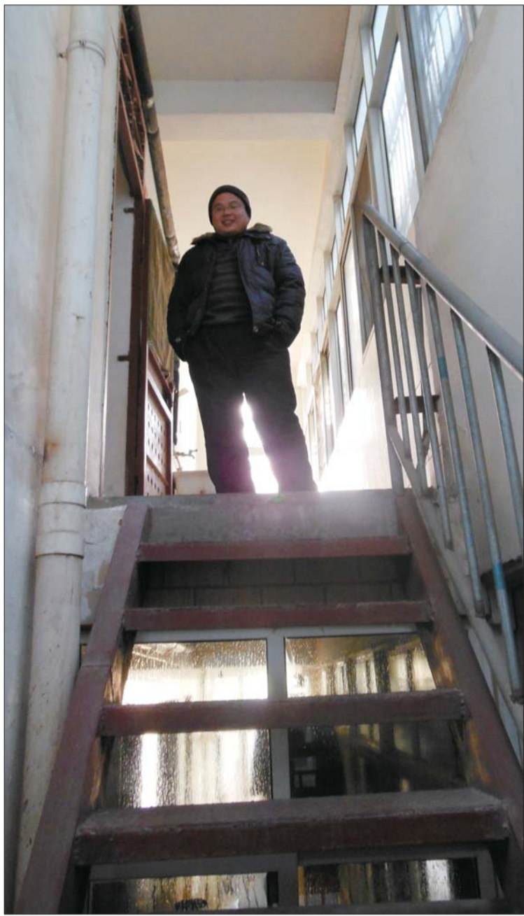
▲通向李小松房间的楼梯很狭窄,是房主自己焊接的。
