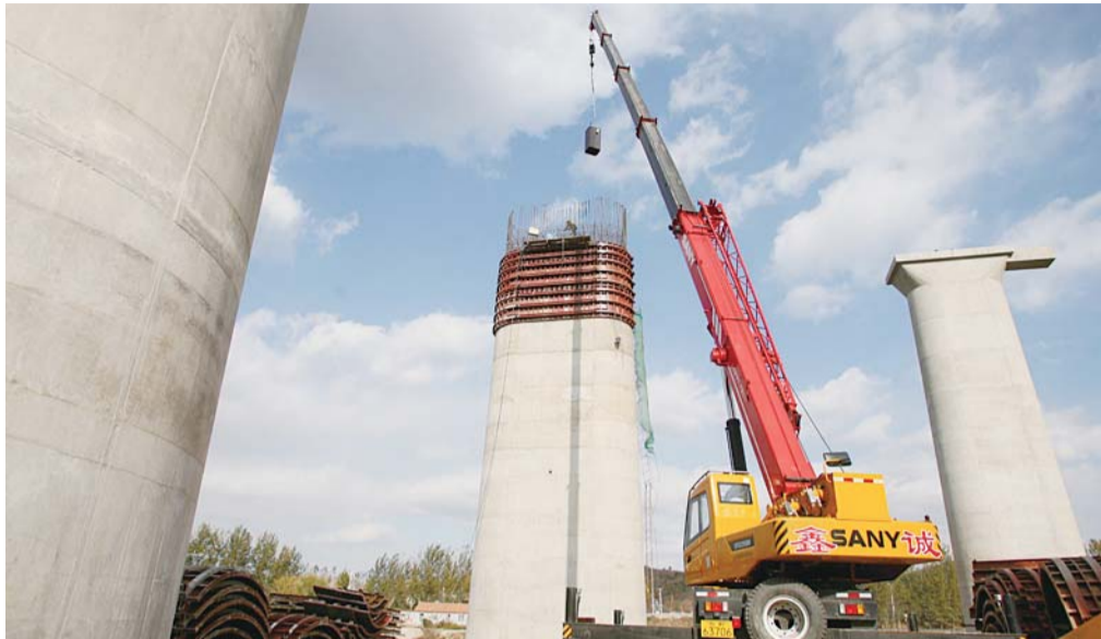
青荣城际铁路跨外夹河大桥的桥墩建设已基本完工。记者 赵金阳 摄
