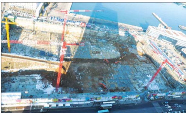
大悦城施工现场
