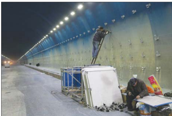
嵩山隧道内部改造已经基本完成。程志强 摄
