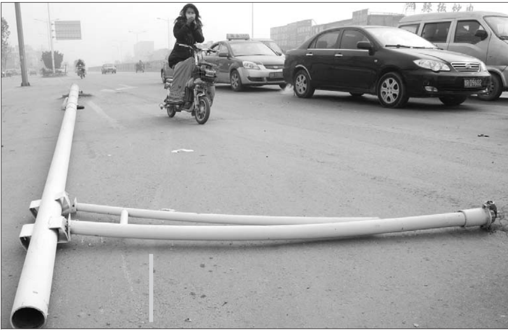
9日,市民张先生拨打本报热线反映,黄河路与青年路交叉口一根路灯完全倒地,阻碍交通。本报记者在现场看到,一根十米左右的路灯杆自东向西横躺在黄河路上,几根粗粗的电线暴露在外。记者拨打菏泽市路灯管理所办公室电话,工作人员表示马上对该路灯进行更换。 本报记者 邓兴宇 摄影报道
