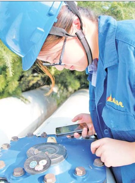
热电厂工作人员在用秒表计算管道内供水流量。 记者 王震 摄
