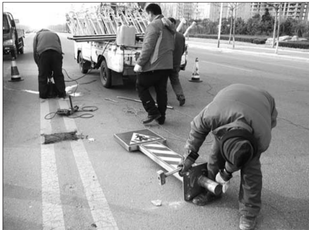
1月11日,在迎宾路上,施工人员正在对原有的护栏进行整改。 本报记者 徐艳 摄
