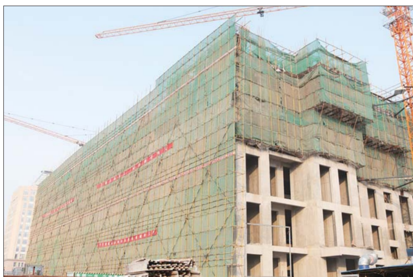
新玛特建设现场。
