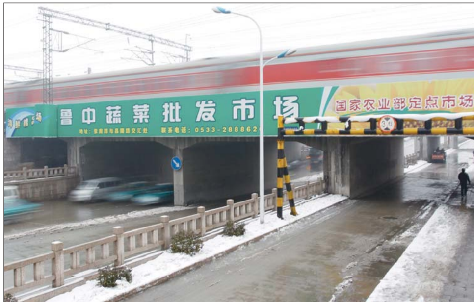
▲即将施工的张店西二路铁路桥。 本报记者 王鑫 摄
