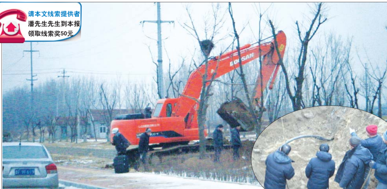
▲工作人员在电缆抢修现场忙碌。
