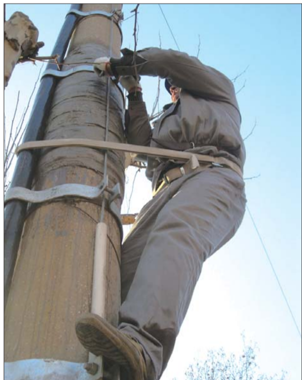
工作人员正在进行线路改造。记者 孙淑玉 摄
