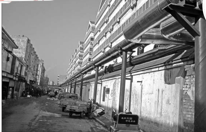
遮雨棚已经被拆除完毕。本报见习记者 王洪磊 摄
