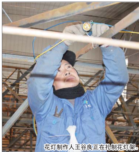
花灯制作者杨董正在花灯架上栓系尼龙管,以固定霓虹灯线。
