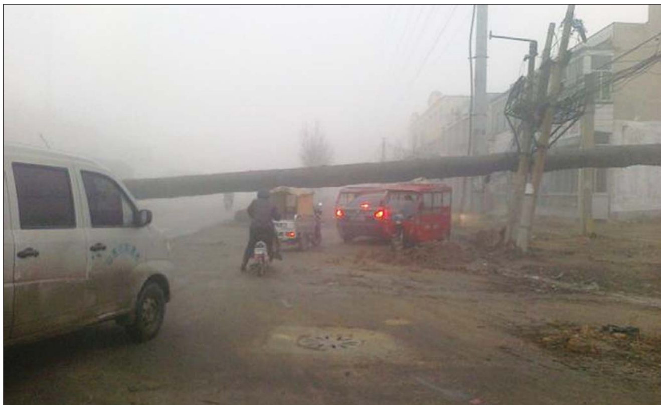
31日上午,在临清城区北环路二棉厂附近,一横跨马路的供热管道坠落。(网友提供)
