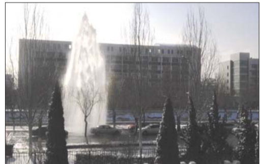
自来水管破裂,喷出的水柱10米多高。
