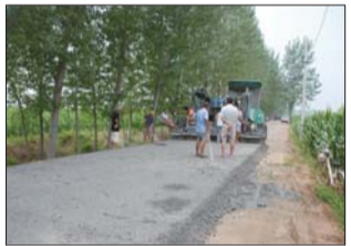
二灰碎石摊铺。
