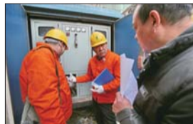
向客户当面说明设备隐患及整改措施
