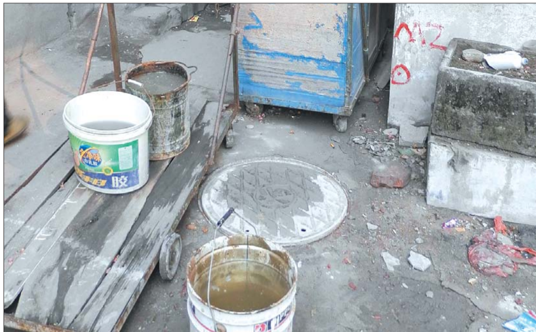
由于下水道堵塞,污水外溢,居民只好每天用水桶往外清理溢出的污水。 实习生 王慧 摄
