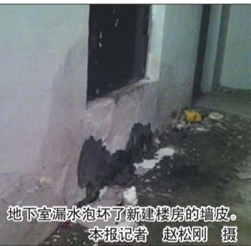
地下室漏水泡坏了新建楼房的墙皮。本报记者 赵松刚 摄
