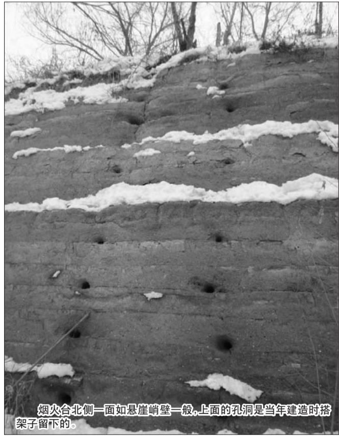
烟火台北侧一面如悬崖峭壁一般,上面的孔洞是当年建造时搭架子留下的。
