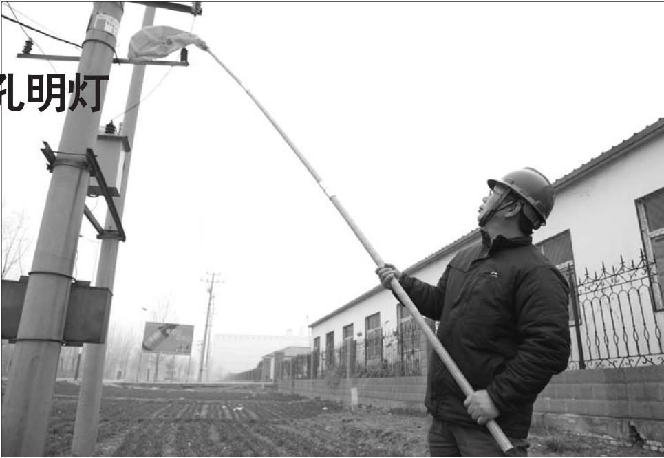
供电工人正拿着竹竿清理挂在电线上的孔明灯。
