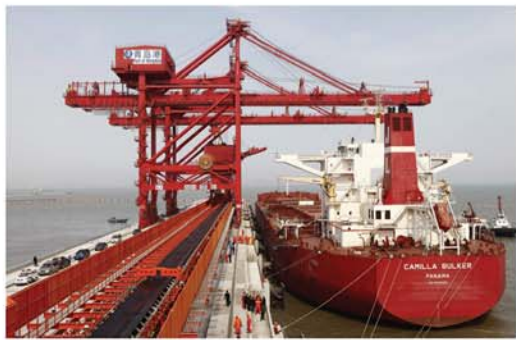
董家口港40万吨矿石码头。
