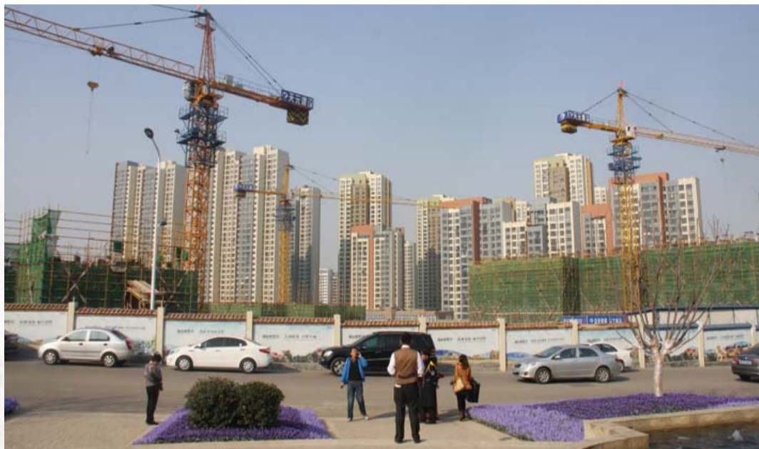
鲁能领秀城施工现场
