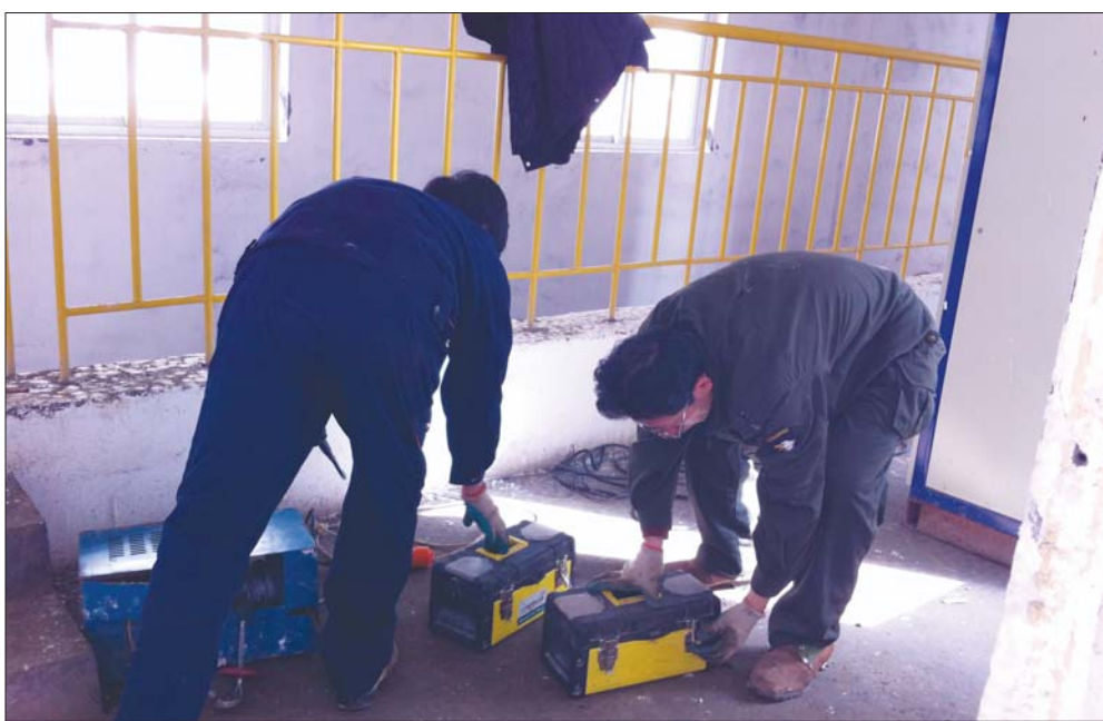
自来水公司的维修师傅在现场维修。记者 刘杭慧 摄
