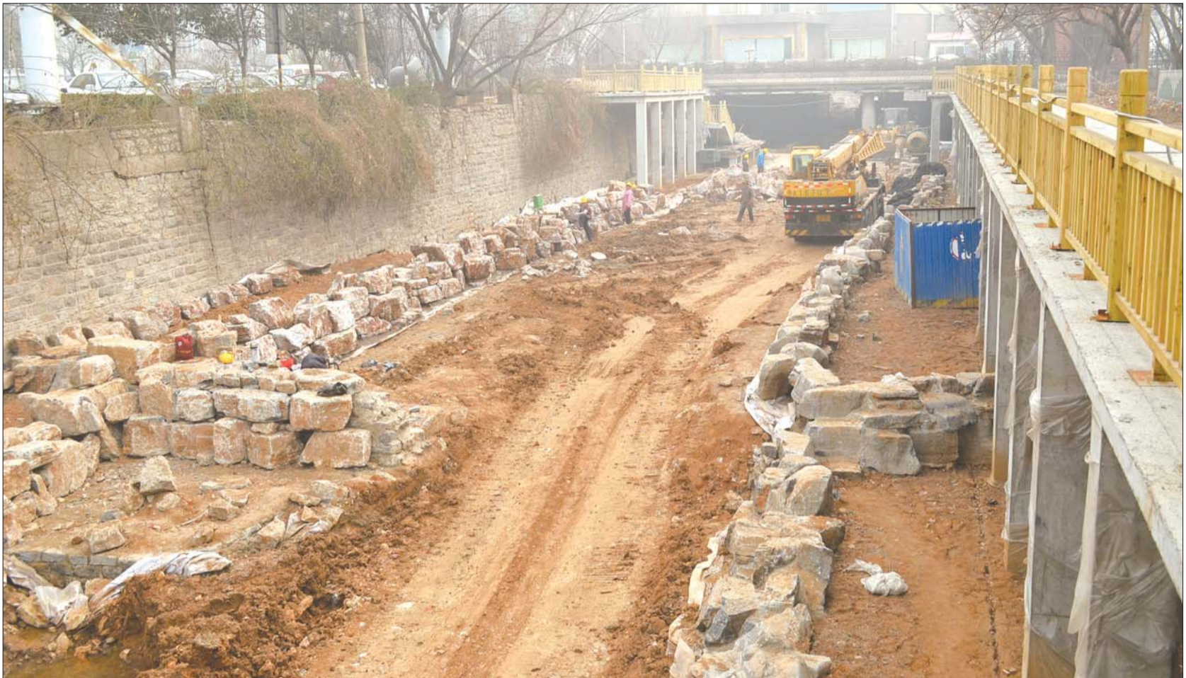
市政部门工作人员正在对城区内河道进行治理,打造水体景观。
