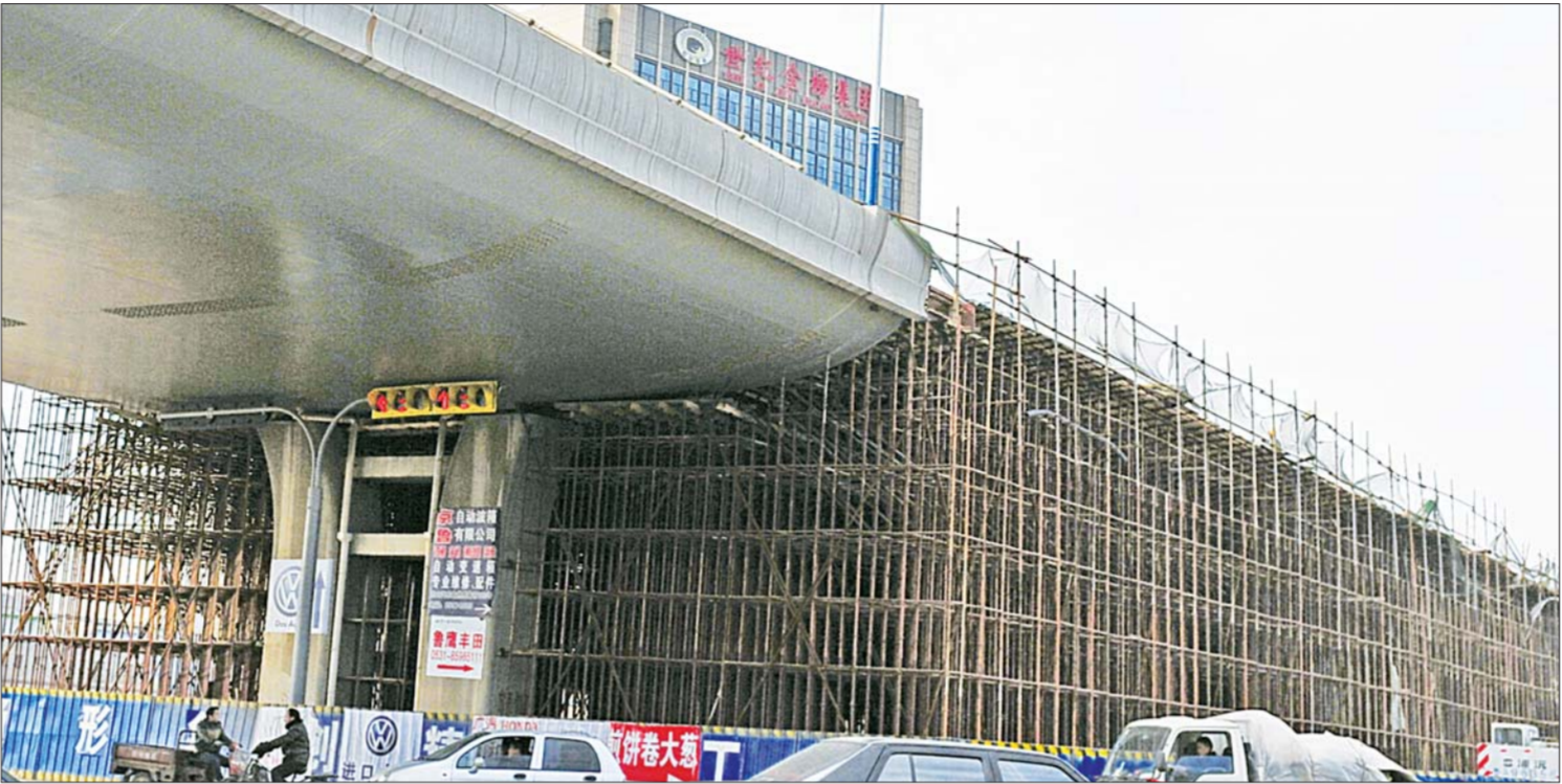
3月4日,北园高架路西延工程现场,工人们正在紧张施工,延长部分桥面的模板已经和旧桥面接轨,形成水平面。本报记者 周青先 摄
