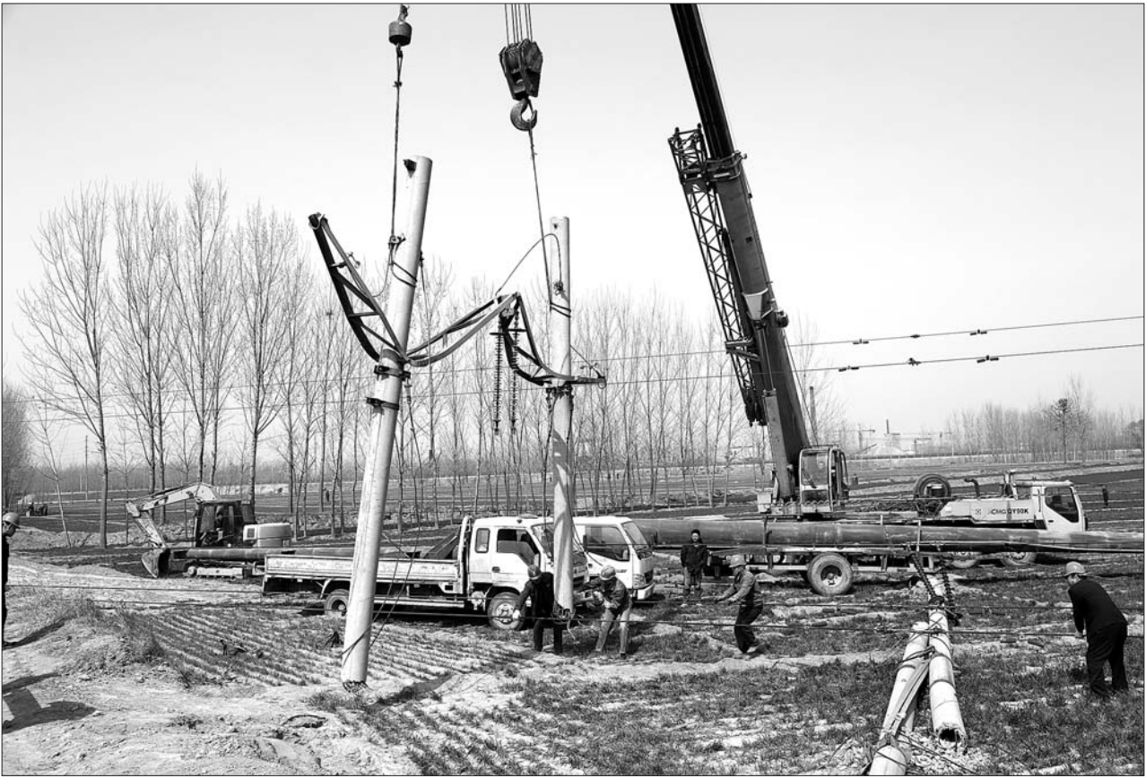
▲供电部门对线路进行抢修。
