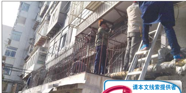
工人正在抢修线缆。记者苑菲菲 摄
