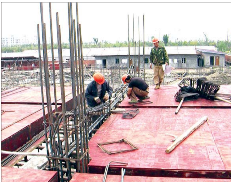
使用在工地上的建筑模板(红色的覆盖物)。(资料图)
