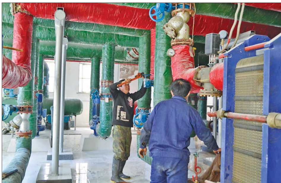
东营部分地区供暖延长三天,13日,东营安泰社区换热站工作人员正在检修供暖管线。本报记者 孙娜娜 摄
