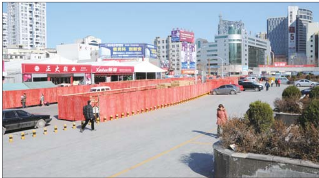
工人们在工地周围围上木板开始施工。记者 李大鹏 摄
